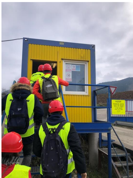
Stavebná búda pri váhe pre vozidlá
