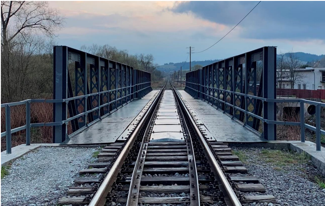
10. miesto - Trať s mostom v Rakovej
